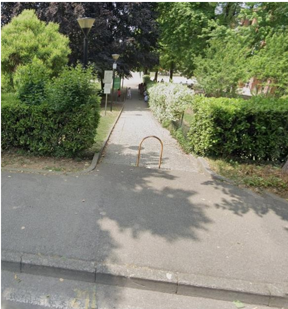
Pendenza eccessiva della rampa
